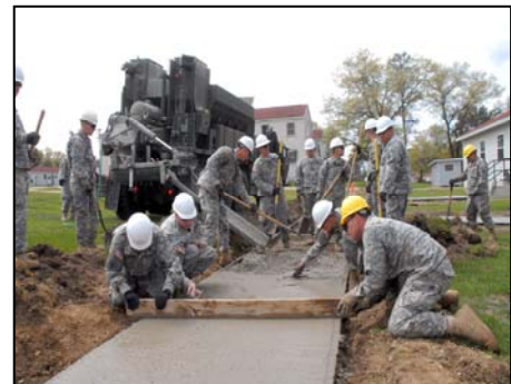
Engineers Pour Concrete
